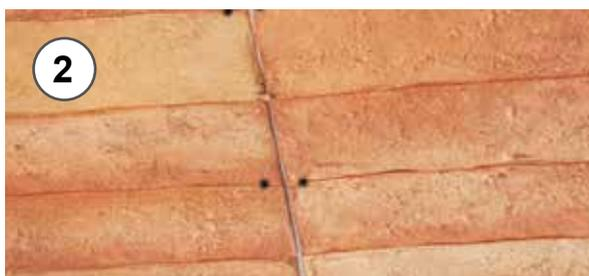
**2 - Fissaggio pannello con viti e tasselli collocati in corrispondenza del posizionamento delle travi.**
