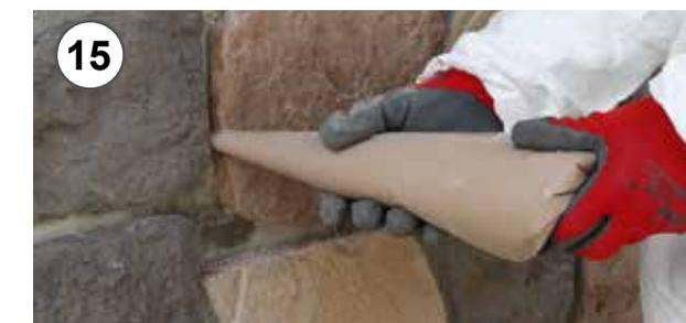
**15** - Applicazione dello stucco mediante sac a poche
