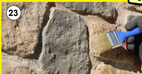
**23** - Per ottenere una colorazione uniforme, oltre a colorare il giunto ricostruito, sfumare sui giunti adiacenti
