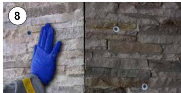
**8** - Ad incollaggio ed indurimento avvenuto rimozione di viti e rondelle precedentemente posizionate
