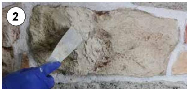
2- Applicazione dello stucco mediante spatola
