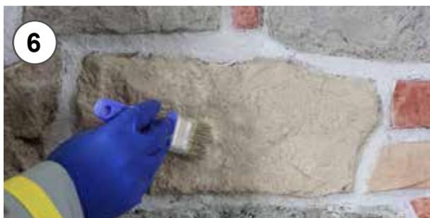
9 - Ossidatura della pietra ricostruita da effettuare a completa asciugatura dello stucco utilizzato per la ricostruzione
