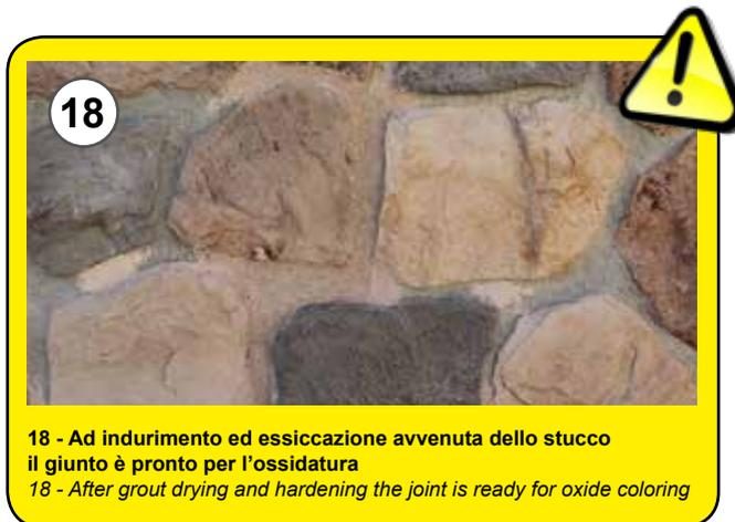
**18** - Ad indurimento ed essiccazione avvenuta dello stucco il giunto è pronto per l'ossidatura
