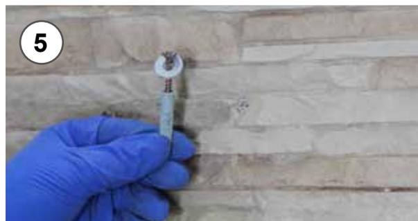
5 - Fissaggio meccanico provvisorio con viti e rondelle
