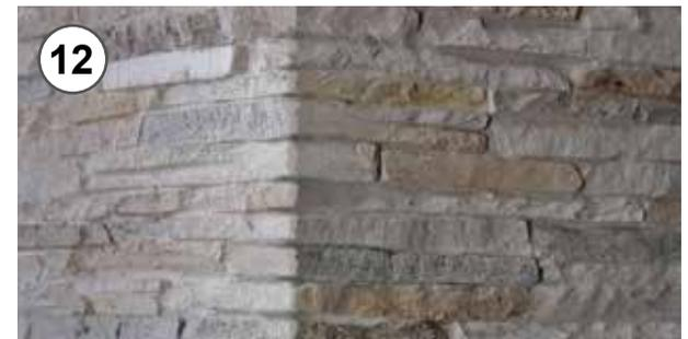
12 - L'angolo pronto per la colorazione con gli ossidi **da effettuare a completa asciugatura dello stucco**
