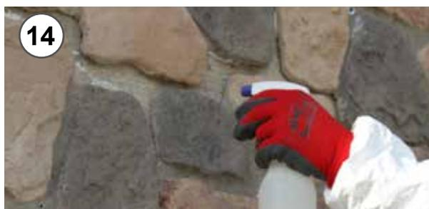
**14** - Umidificazione del giunto con acqua nebulizzata prima dell'applicazione dello stucco
