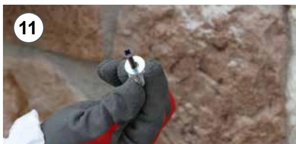
**11** - Fissaggio provvisorio del pannello con viti e rondelle sino a presa della schiuma
